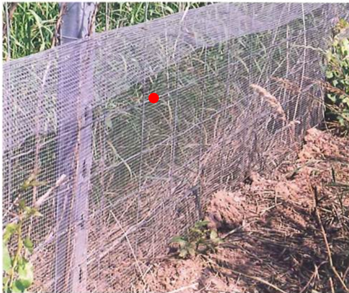
Figure 41 : Grillage soudé de 6 x 6 mm. La partie supérieure est recourbée pour empêcher les animaux d'escalader.
